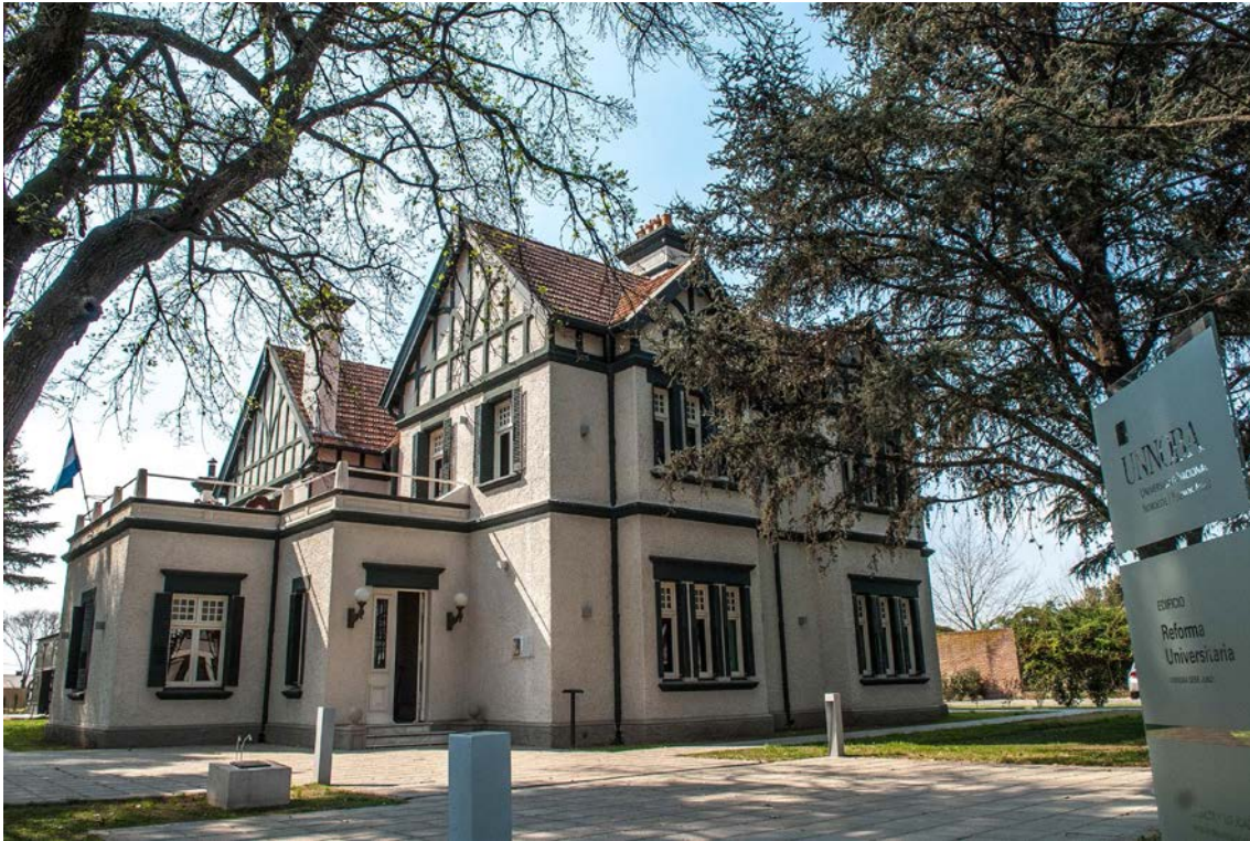
Edificio Reforma Universitaria | Rectorado
