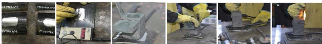
Figura 1 a-f: Procedimiento llevado a cabo para la realización de la soldadura cuproaluminotérmica.
